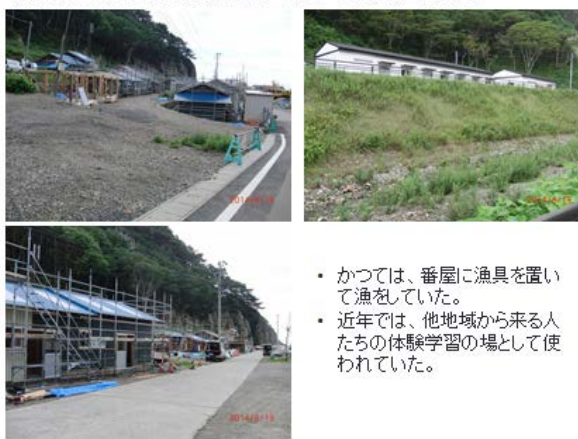
机漁港番屋再建現場(左)と対岸の漁具置場(右)
