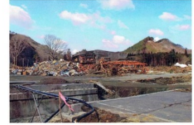
堤が潰れ、道路が寸断。集落施設も流出してしまった
